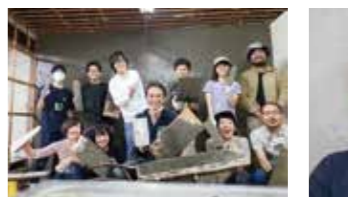
にぎやかな空き家改修の様子
